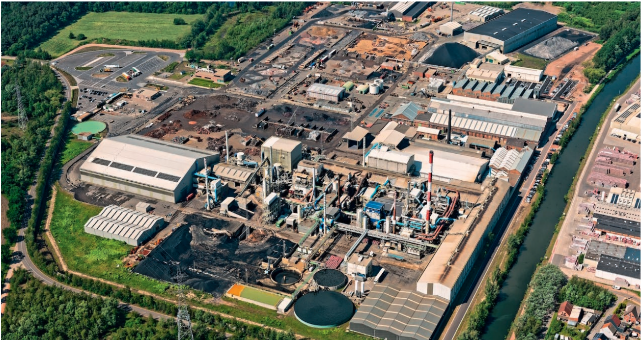
Blick auf den belgischen Standort Aurubis Beerse nv, auf dem Gelände die ASPA-Anlage gebaut wird
